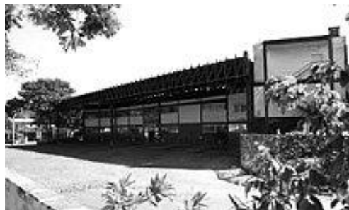
5ª Rodoviária de Lajeado Av. Presidente Castelo Branco, 42
